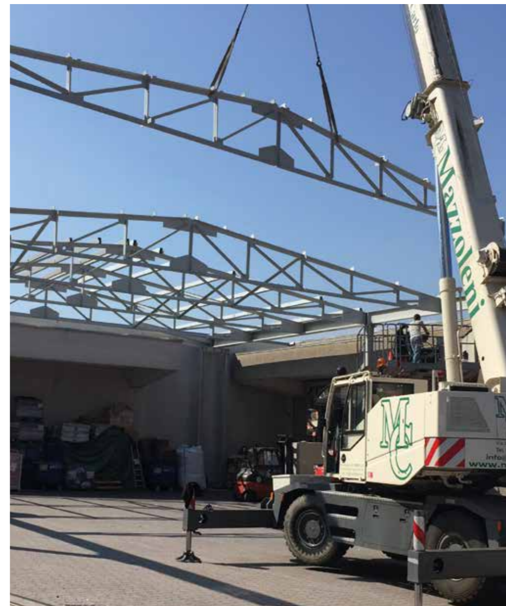
CAPANNONE IN ACCIAIO
