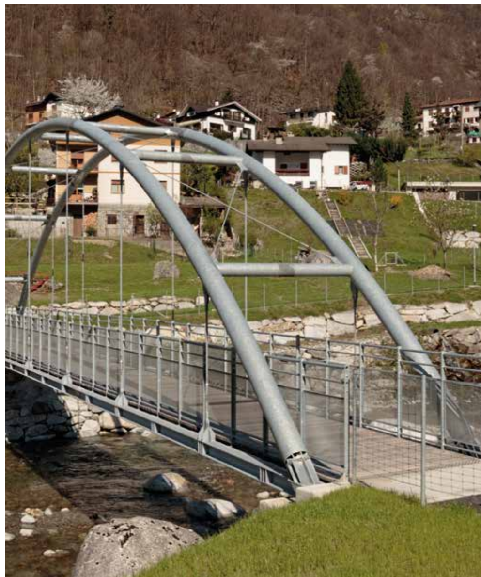
PASSERELLA PEDONALE SAN GIACOMO FILIPPO (SO)
