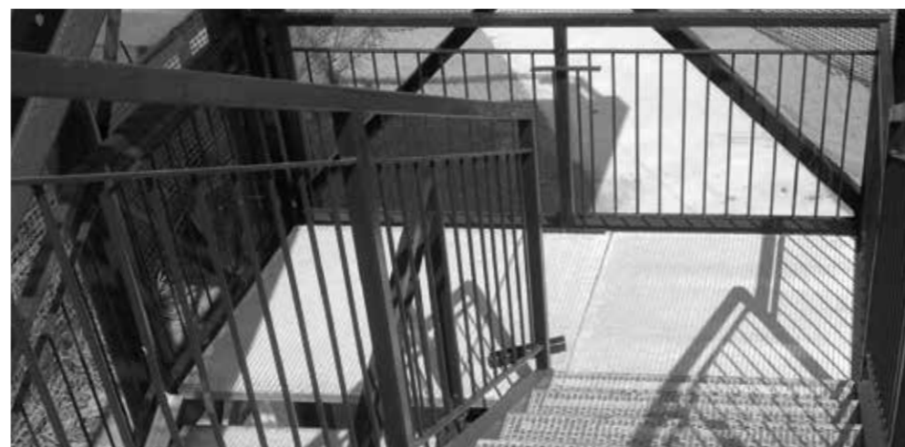
PASSERELLA CICLO PEDONALE BARANZATE (MI)
