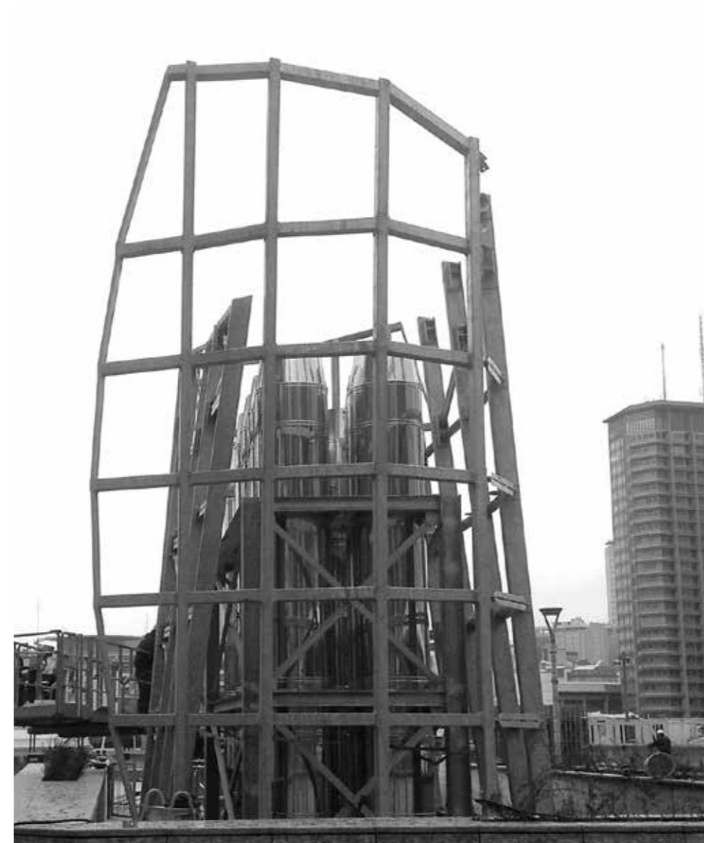
STRUTTURA IN ACCIAIO CANTIERE HINES VIA SASSETTI (MI)
