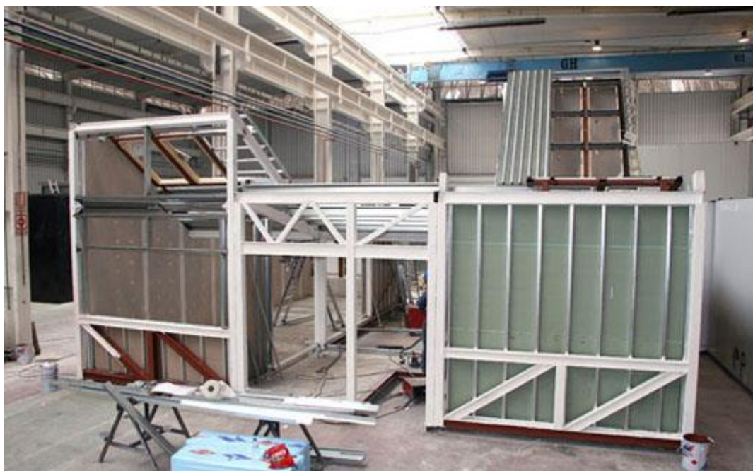
Assemblaggio delle strutture portanti del "Velux Lab" © Atelier2 Gallotti & Imperadori Associati
