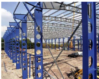
Fig. 1. La struttura portante in acciaio di un edificio industriale monopiano
