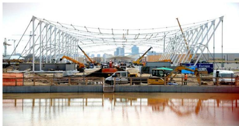
**Gli elementi portanti sono realizzati con tubi strutturali (Ø 323,9 mm), tiranti in barre piene (da 52 a 100 mm) e controventi anch'essi in barre piene (Ø 27mm). Funi portanti e stabilizzanti sono del tipo a trefoli paralleli. I collegamenti sono totalmente bullonati. Tutti gli elementi strutturali, barre e profili cavi, sono in acciaio S355J, zincati e verniciati.**
