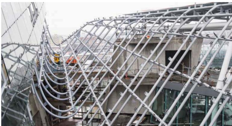
La definizione della tipologia di vetro impiegato nelle differenti porzioni di superficie è stata particolarmente accurata: circa 2.000 fissaggi puntuali sono stati studiati ad hoc per sostenere vetri stratificati, vetrocarmera ed elementi fotovoltaici planari o curvi. **Palazzo Italia, conclusa l’esposizione universale, resterà un’opera permanente e vince così le sfide dell’innovazione e della sostenibilità.**
