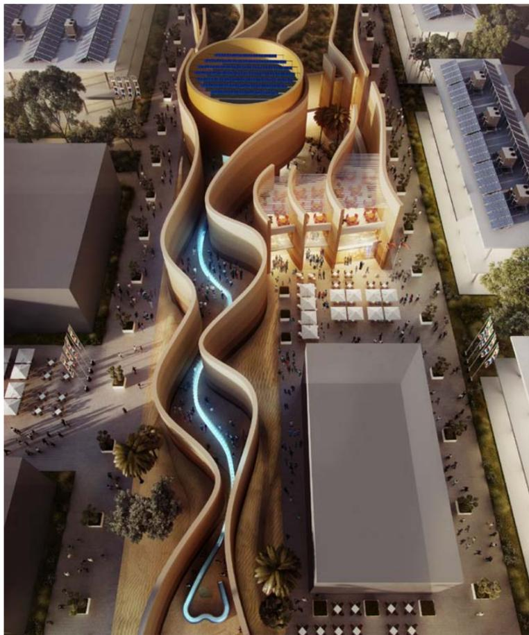
**Tutti gli elementi in acciaio, in qualità S355J2 per 1.000 tonnellate complessive, sono giuntati mediante bulloni, in modo da favorire il disassemblaggio dell'edificio in situ, per poi trasportare le parti negli Emirati Arabi Uniti a conclusione dell'esposizione universale, costituendo un legame storico tra le due edizioni di EXPO al quale l'acciaio porrà una firma indelebile.**
