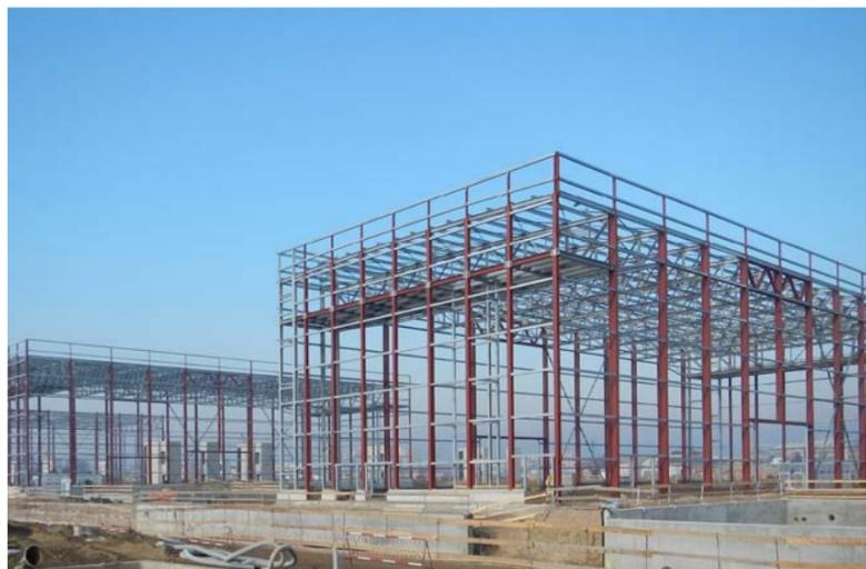
Gli arcarecci sono in profilati tipo IPE 220. Profili angolari 60x8 mm disposti a croce di Sant'Andrea sono utilizzati per i controventi di falda ed "L" 80x8 mm per quelli verticali. Un ulteriore impalcato con profili HEB ed IPE è presente per sorreggere i macchinari interni.
